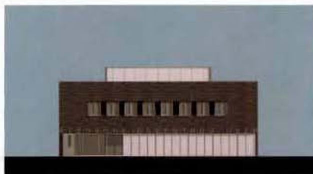
De noordgevel van het gebouw
