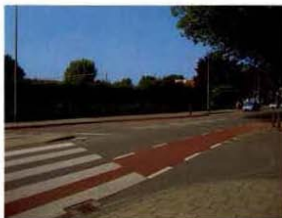
De projectlocatie gezien vanuit noordelijke richting
