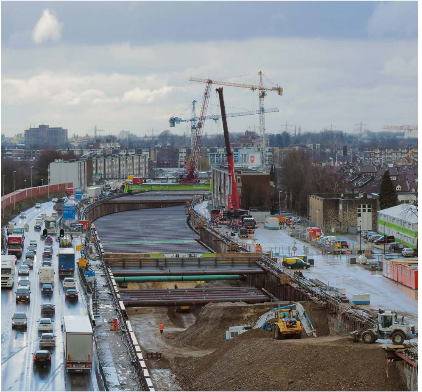
De ondertunneling van de A2
