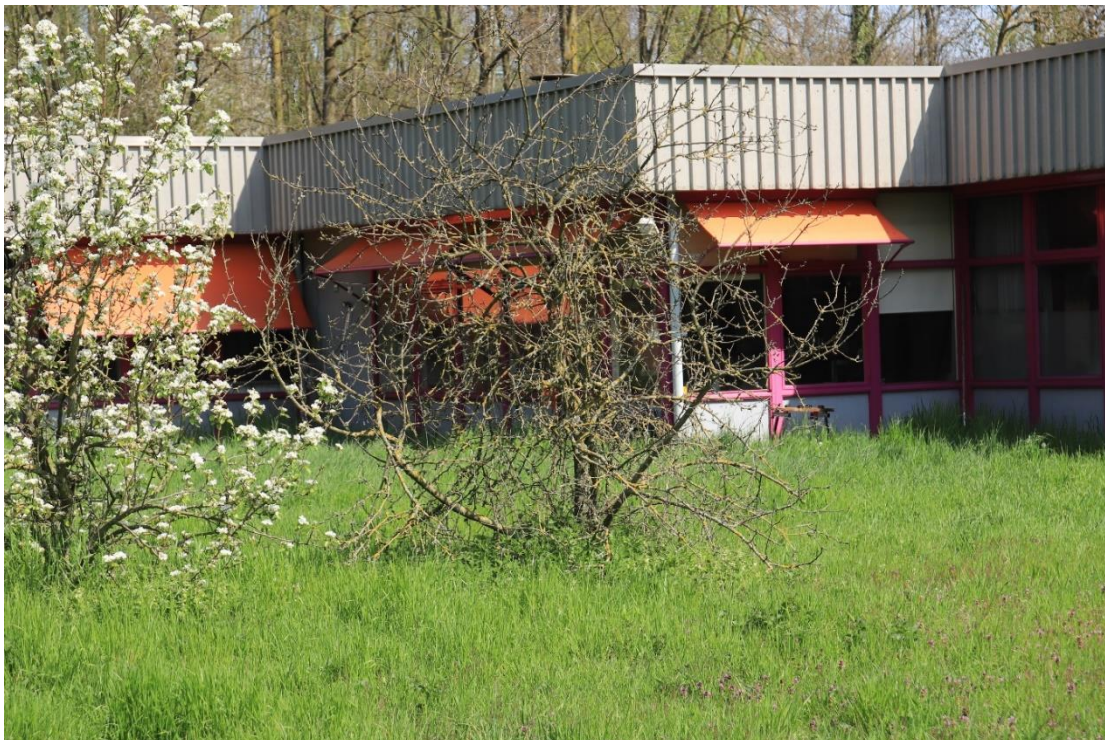
Foto 2: Beeld van de zuidwestzijde van het pand
